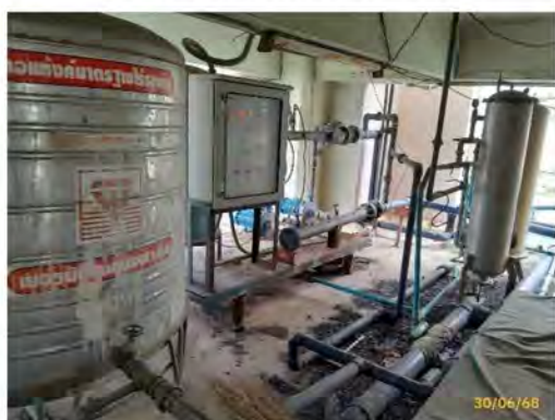
Booster Pump อาคาร A, B
