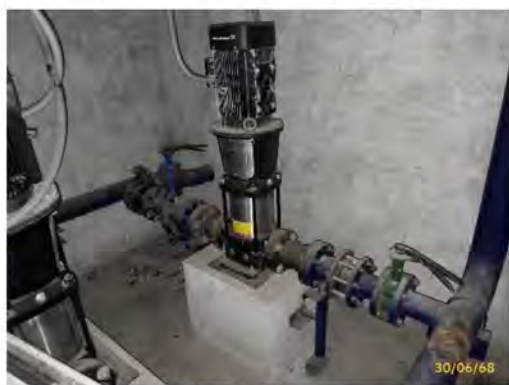
เครื่องปั้มน้ำชั้นใต้ดิน อาคาร C
